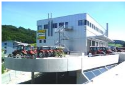
Neubau Ausstellung, Werkstatt und Büros, AGROLINE 6221 Rickenbach Architekt Peter Hofer, 6221 Rickenbach
