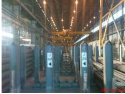
Erweiterung Stahlhalle Swiss Steel AG 6021 Emmenbrücke Ingenieur Brigger + Käch AG, 6015 Reussbühl
